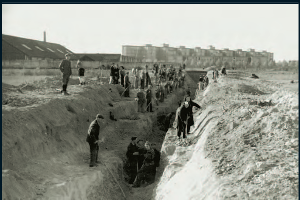
Creusement d'un barrage antichars près de l'hôpital Pasteur
