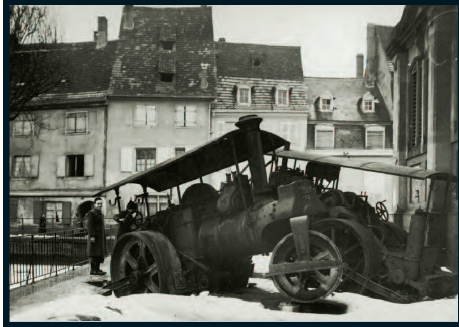
Rouleaux compresseurs servant de barrage sur le pont du Marché couvert
