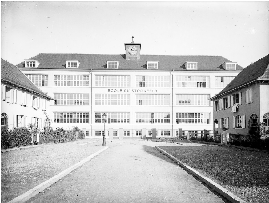
Façade arrière de l'école du Stockfeld. ©Archives de Strasbourg, 1 OS 1552 -1.
