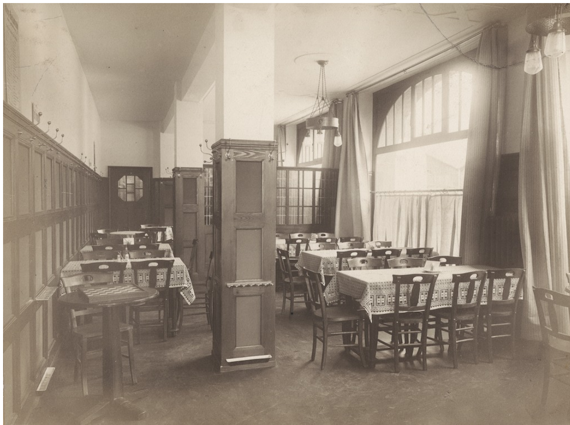
FOYER DU CÉLIBATAIRE : LA SALLE DE RESTAURATION. ©Archives de Strasbourg, 6 OS 225.
