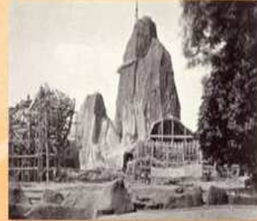
Parc zoologique de Paris, 1934. Construction du grand rocher.
