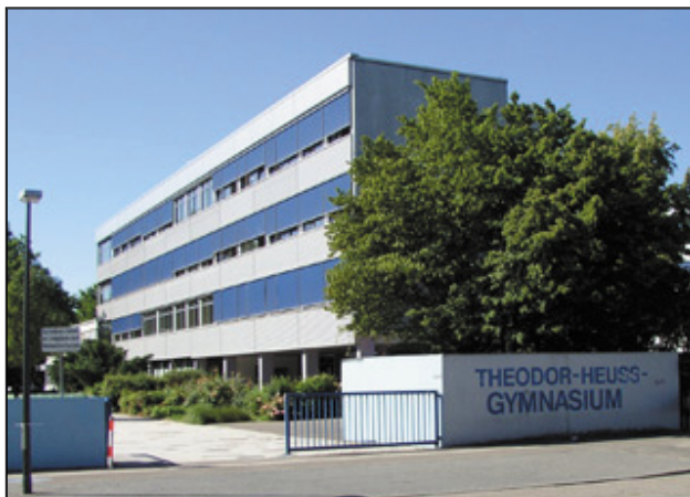
Un lycée (Gymnasium) en Allemagne Photo G. Bräuer LMZ-RP
